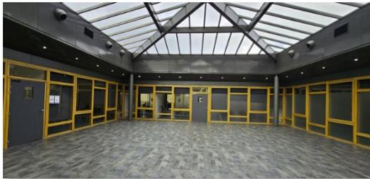
L'immeuble de Trappes est soumis à un risque d'inconfort thermique pour les locataires via sa verrière. En cas de vague de chaleur, les vitrages laissent passer les rayons infrarouges du soleil, ce qui réchauffe l'intérieur du bâtiment. Les locataires sont alors obligés de climatiser l'immeuble.
